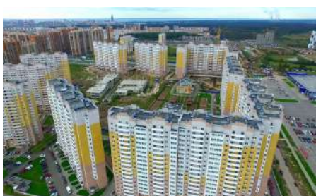
Объект: ЖК «Каменка», г. Санкт-Петербург, 78 квартал, мкр. Каменка Поставщик: ООО «Денеб»
