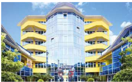
Объект: Гостиница «Атлант», г. Сочи Поставщик: ООО «Теплосервис»
